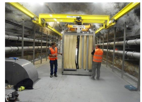
Membrankassette auf dem Weg zum Einbau
