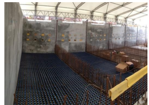
Construction du plancher à buses de la filtration
