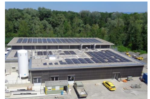
Ozonation et réservoir d'oxygène au premier plan, filtres CAG au second plan
