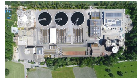
Installations du traitement des micropolluants sur le site de la STEP d'Altenrhein
