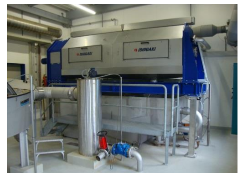
Faulschlammmentwässerung (Schneckenpresse)
