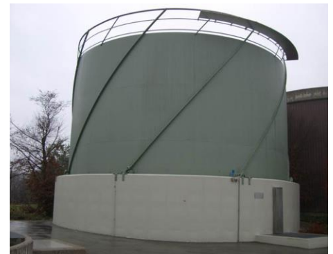
Nassgasometer nach Sanierung
