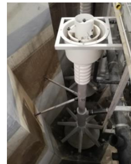
Filtereinheit "DynaSand" ohne Filtermaterial
