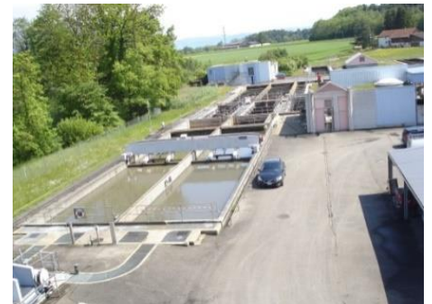
ARA Gelände mit Filtrationsgebäude im Hintergrund
