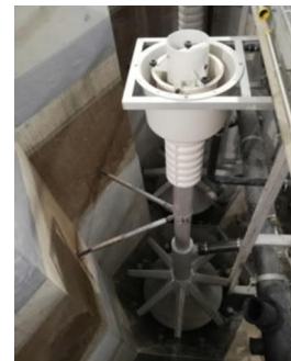
Filtereinheit „DynaSand“ ohne Filtermaterial.
