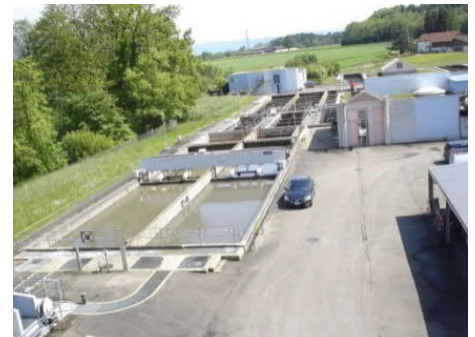
ARA Gelände mit Filtrationsgebäude im Hintergrund.
