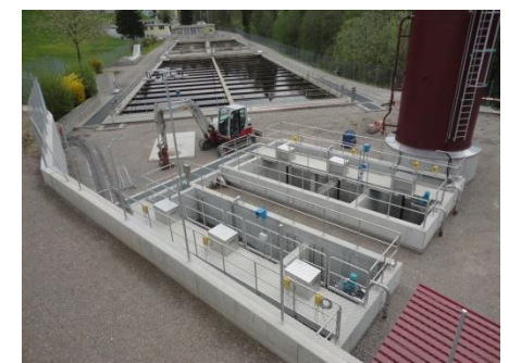
Reaktionsbecken der PAK-Stufe mit PAK-Silo
