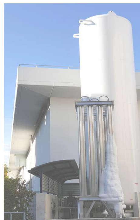
Reinsauerstofftank mit Verdampfer
