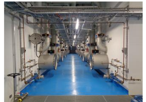
Werkleitungskanal Biofiltration
